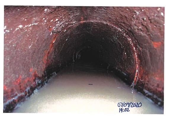
PICTURE # 4105 IS LOOKING DOWN. STREAM INSIDE 8"CLAY
